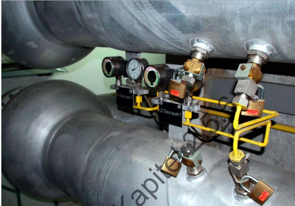
Abbildung 77: Messeinrichtungen zur Überwachung der Gasräume in einer GIL
